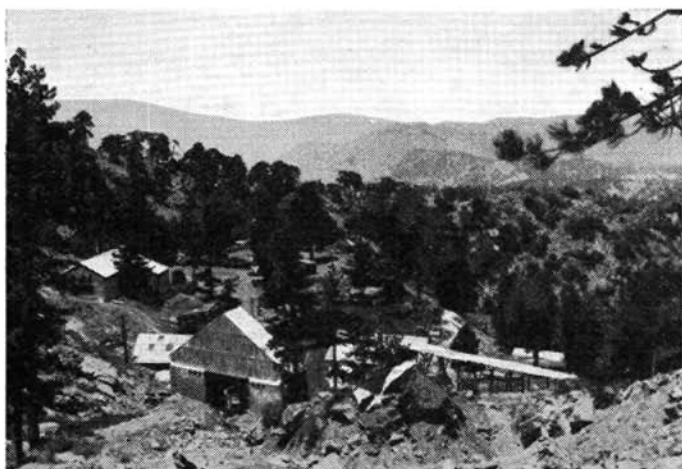
Abb. 5: Der Schacht (mit freistehendem Betongerüst, dreieckig eingedacht) der Troodos-Chromerzgrube, in 1670 m SH, setzt in der Haupt-Dunitzone nieder. — Blick nach Norden.
