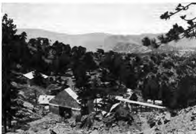
Abb. 5: Der Schacht (mit freistehendem Betongerüst, dreieckig eingedacht) der Troodos-Chromerzgrube, in 1670 m SH, setzt in der Haupt-Dunitzone nieder. — Blick nach Norden.
