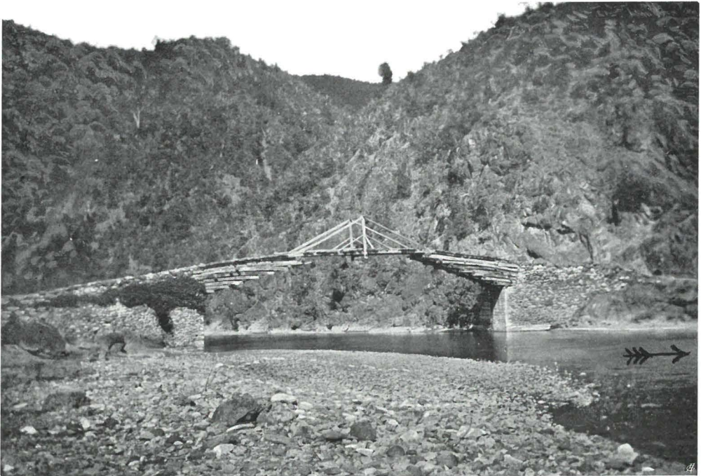
Brücke über den großen Fani «Vau maž» beim Dorfe Pšćeš
