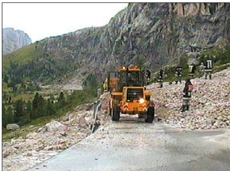
Die Straße zum Grödner Joch wurde von der Mure verlegt und musste aus Sicherheitsgründen gesperrt werden. RA
