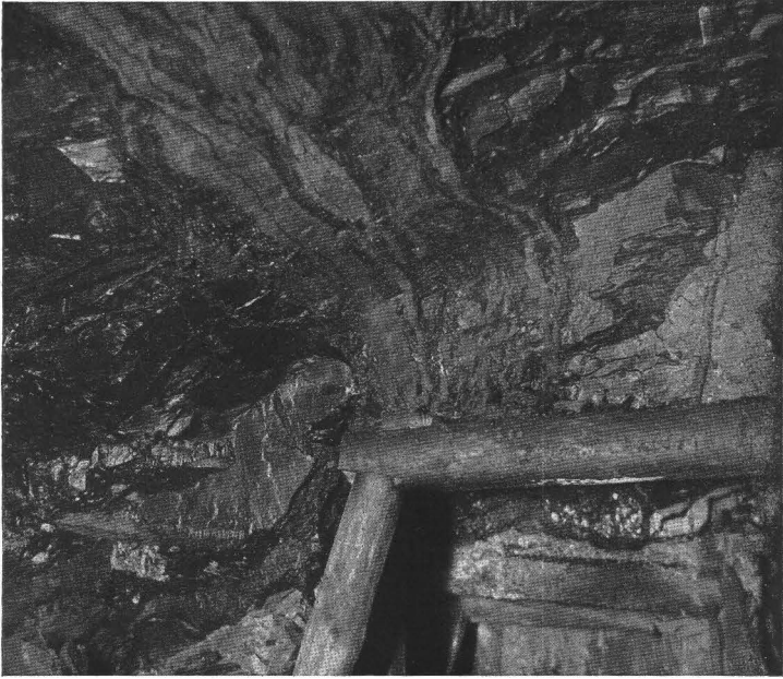
Fig. 1. Zusammengesetzter Sand-Glanzkohlelang mit Seitentrums im First einer Abbaustrecke des Busseflözes. Phot. H. LAMPE.
