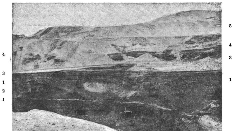
Fig. 7. Tagbau am Fügner-Schacht. 1. Hauptflöz, 2. Verkieselte Lage im Hauptflöz, 3. Zwischenmittel, 4. Oberflöz, 5. Hangendsande mit Dünen-Struktur. — Nach einer Photographie von G. Laube in Bilin.
