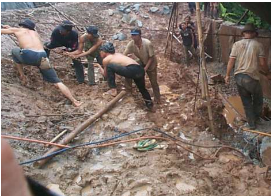
Abb. 2: Baustellenbetrieb bei ungünstigen Witterungsverhältnissen
