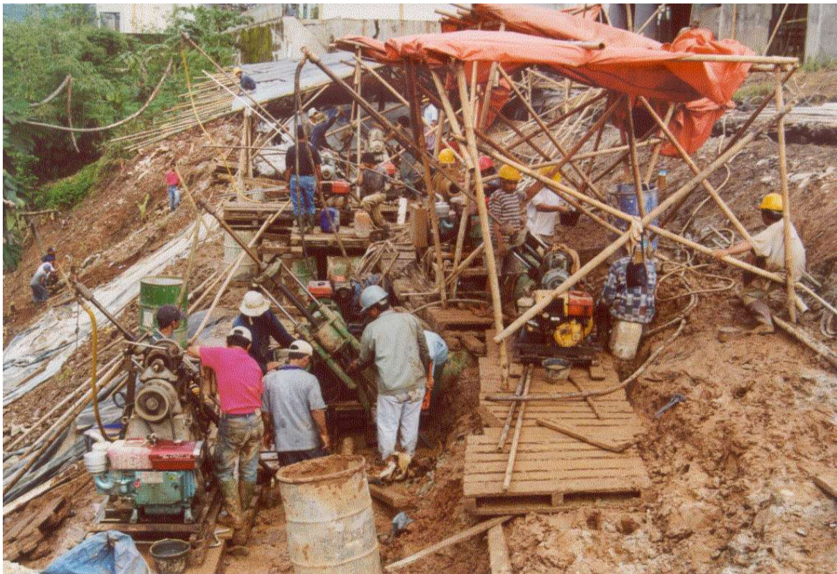
Abb. 3: Herstellen von Ankerbohrungen
