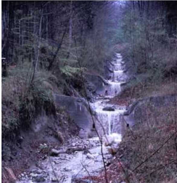
Abb. 9c, d: Die Flachstrecken des Gschlifbaches zwischen den Sperren dienen auch als Auffang- und Sedimentationsbecken für Schuttfracht und sollten daher regelmäßig ausgebaggert werden (links, Foto: J.T. Weidinger 2005); Profilschnitte der in Abb. 9b gezeigten Drainagekanäle (rechts, nach Pokorny 1894).
