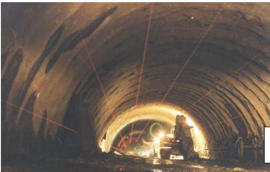
Abb. 3: Vortrieb und Vermessung im Umfahrungstunnel von Traunkirchen
