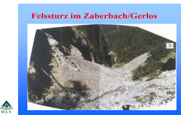
Abb. 8: Bruchkesselbereich (Detail aus Abb. 7)
