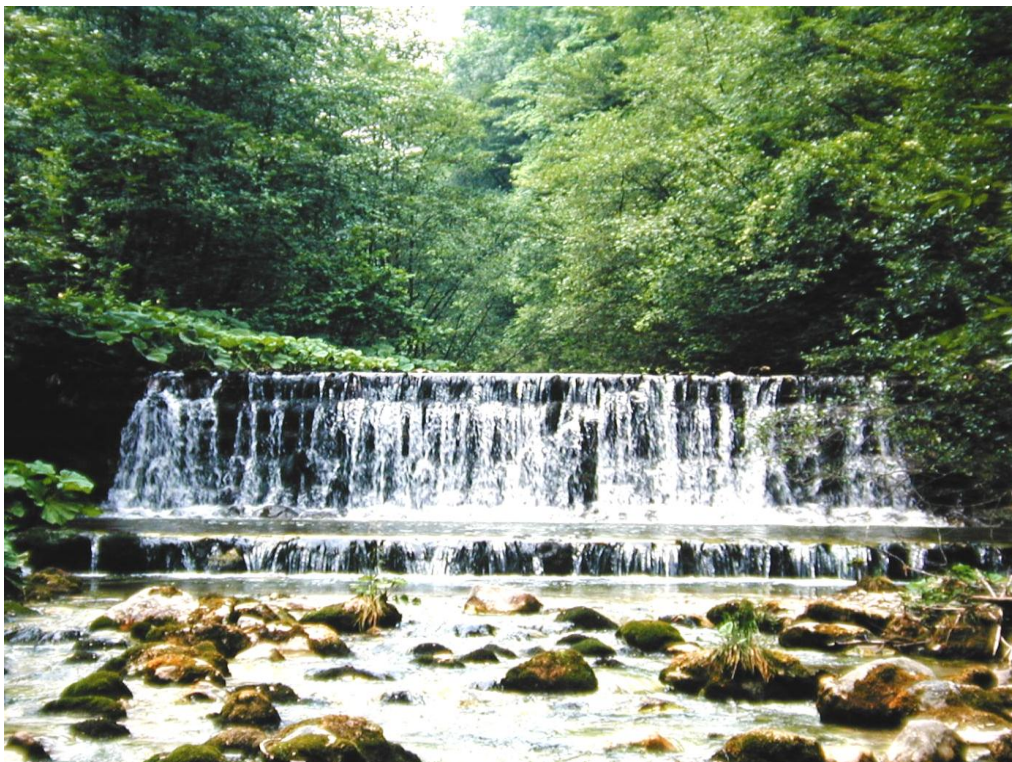
Abb. 4: Zu Beginn des 20. Jahrhunderts wurde für den Langbathbach ein umfassendes Sanierungsprojekt ausgearbeitet und umgesetzt.
