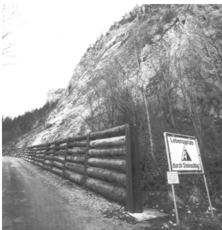
Abb. 14: Bohlenwand nahe der Ansetz als Schutz vor Steinschlag aus der Traunstein-Westwand
