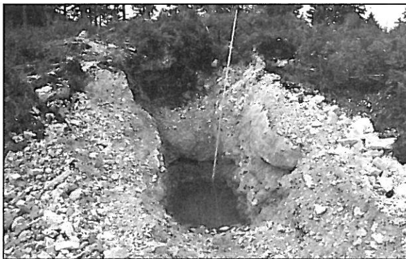
Abb. 1: Durch Bohren, Sprengen und anschließendes Ausbaggern hergestellte Schürfe zur Beurteilung einer Dolomitlagerstätte; St. Gilgen
