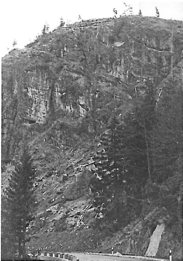
Abb. 3 Zustand der Felswand vor Beginn des Abbaus, unten die B308
