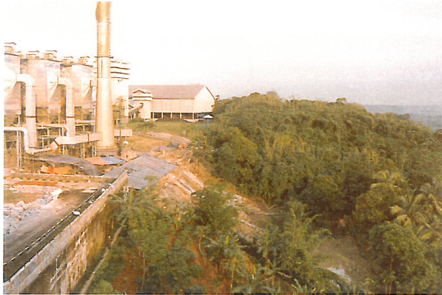
Abb. 2: betroffener Hangbereich neben der Energieanlage
