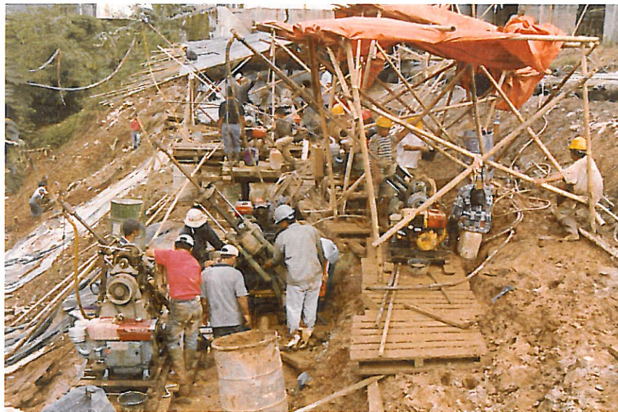
Abb. 3: Bohrarbeiten für die Rückverankerung der Spritzbetonsicherung
