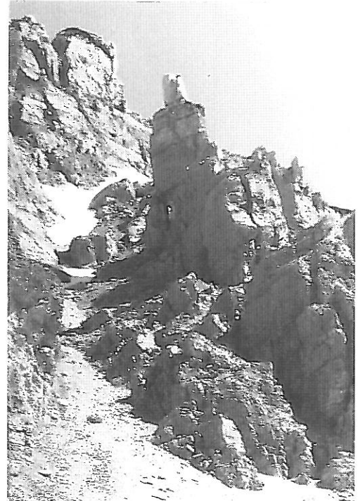
↑ Abb. 26: Abrissbereich des Sandling Bergsturzes von 1920; stark zerrüttete und Absturz-gefährdete Felsmasse.
