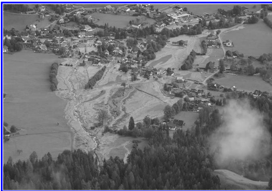
Abbildung 03: Ablagerungen am Schwemmkegel des Tronitzerbachs, Gemeinde Afritz am See. Figure 03: Debris flow deposits on the fan of the Tronitzer creek, community Afritz am See. Quelle: GLB Kärnten Nordost, WLV
