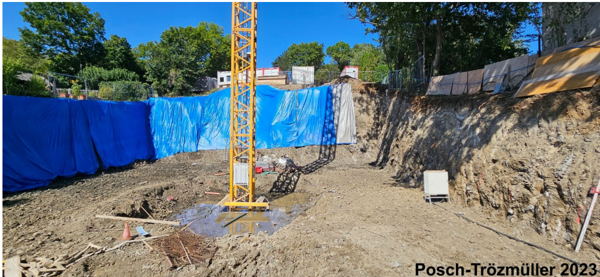
Abb. 4.21.: Blick von der Hauptstraße in die Baugrube Hauptstraße 80-82.
