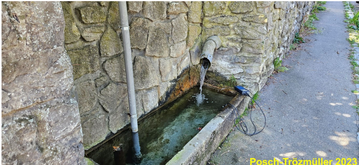
Abb. 4.26.: Aus Grundwasser gespeister Brunnen an der Gießhübler Straße 57.
