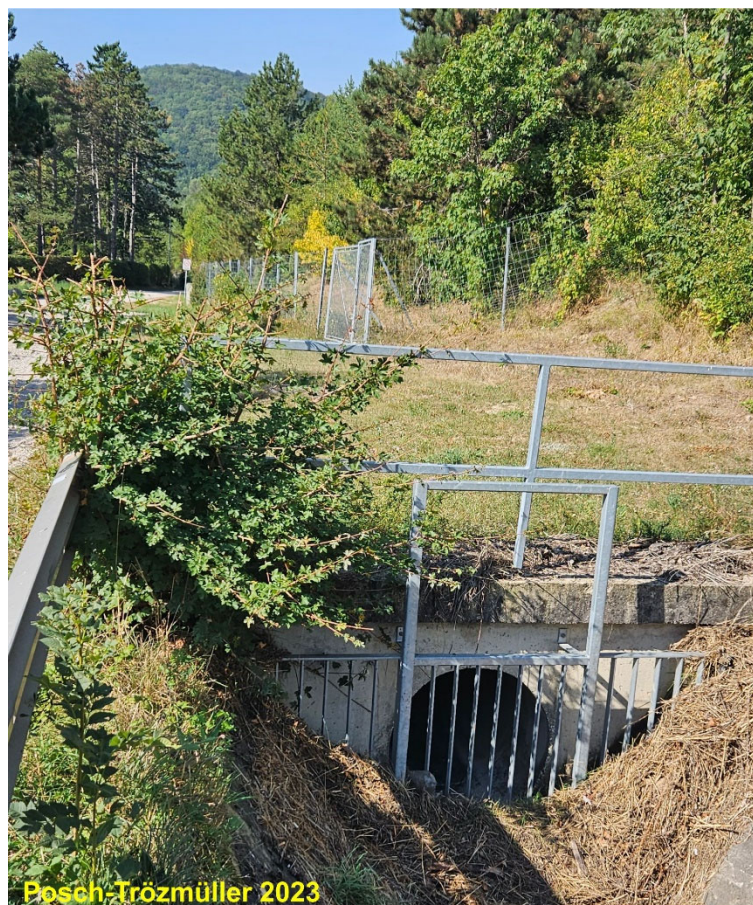
Abb. 4.9.: Schachtbauwerk, an welchem die autobahnparallele, betonierte Rinne endet (Blickrichtung W).
