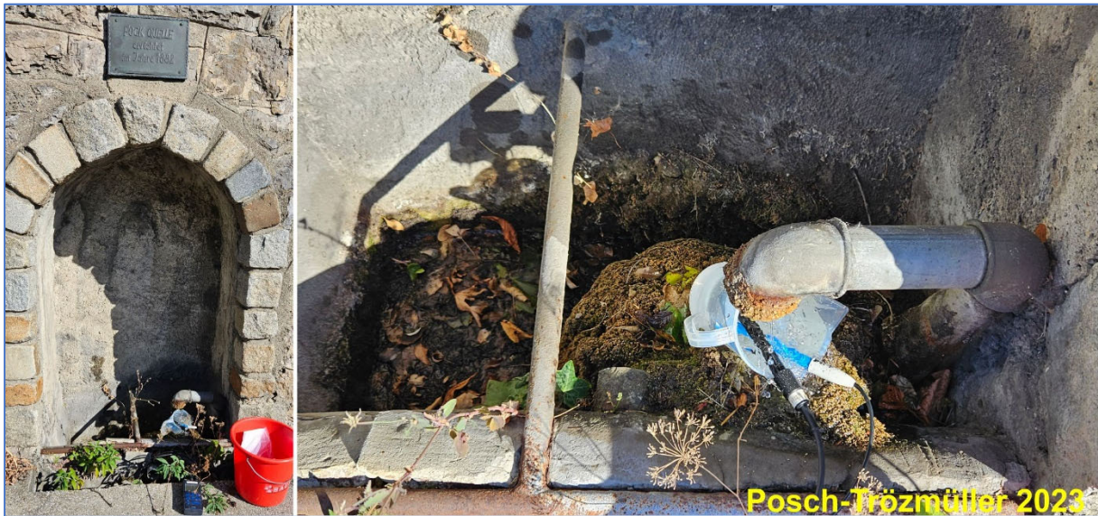
Abb. 4.28.: Fockquelle an der Johannesstraße, rechts ist unter dem Rohr ein Sinterkegel zu sehen.
