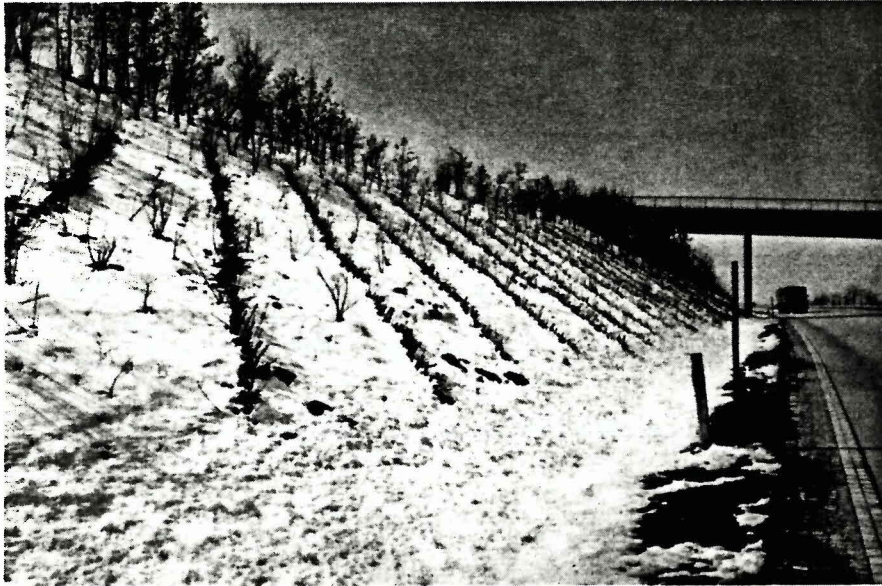
Abb.VII. Grünverbauung einer Autobahnböschung mittels Weidenspreitlagen
