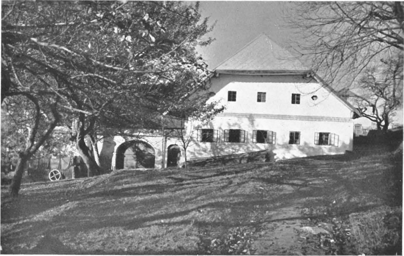
Bild 1. Hof „Bauer in Laimbach“, rd. 770 m; sehr wahrscheinlich ältester Hof von Ober- und Unterlaimbach, Gem. Leonfelden. Großer Halbwaln, getünchte Mauern, 5-Fensterfront. Typisch für die ältere Bauweise. Zu S. 93 u. 95/96.
