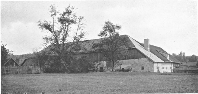
Bild 2. Derselbe Hof von rückwärts; den Halbwalmdächern der anderen Seite entspricht ein langes trapezförmiges Dach. Zu S. 99.
