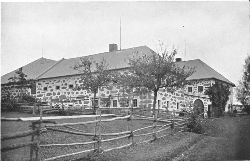
Bild 2. Hof Kahr, Amesschlag Nr. 5, Gem. Amesberg. Neubau nach Blitzschlag und Einäscherung 1914. Granitblöcke, Walmdächer über dem oberen Stock. Zu S. 93 u. 95.
