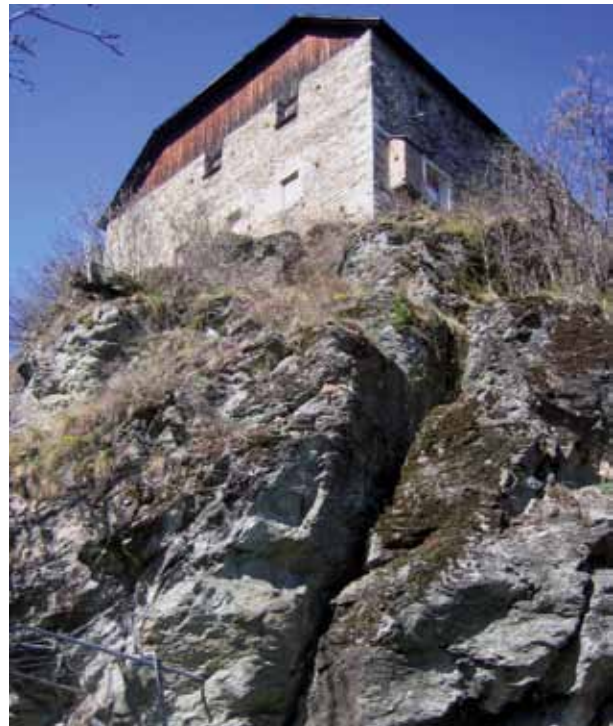
Abb. 2: Schloss Summersberg steht auf Amphibolit; das Gestein ist völlig zerklüftet und besitzt eine hellgrüne Farbe.
