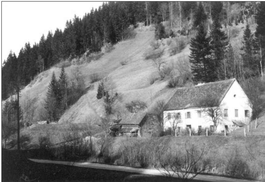
Abb. 2: Grubenhaus vor dem Raabstollen; eines des ältesten Häuser in Arzberg (Bauzustand 1962; Foto: G. NEURATH 1962).
