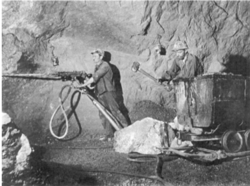
Abb. 7: Arbeiten im Grubenbau Etage XIV (Fotosammlung Mag. A. Leitner).
