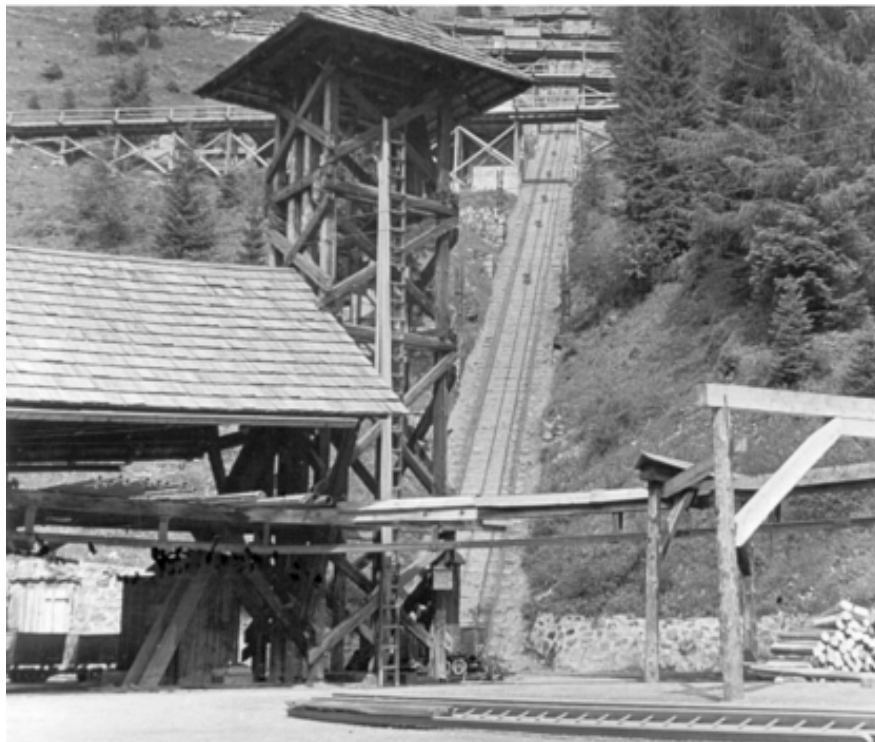
Abb. 3: Bremsberg im Magnesitbergbau (Fotosammlung Mag. A. Leitner).
