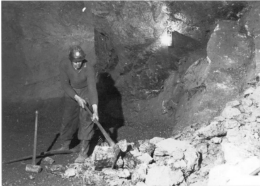
Abb. 4: Zerkleinerung der Magnesitknauer (Fotosammlung Mag. A. Leitner).
