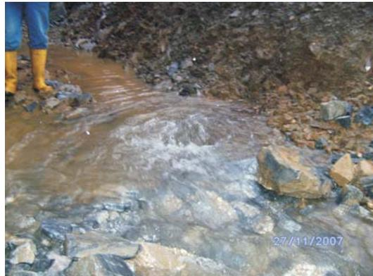
Nach Ausbau der Wasserhaltung spiegelte das Quellwasser in der Brunnenfassung etwa 3,0m über dem Niveau der freigelegten Felsstufe (entspricht etwa der Brunnensohle) auf. Dieses Niveau liegt etwa 1,3m über dem ursprünglichen Wasserspiegel im Bereich des Quelltümpels und etwa 1,0m über dem Niveau der Raab auf Höhe der Finzenquelle.
