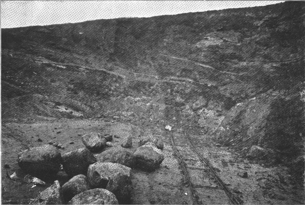
Kiesgrube 4, Neubrandenburg. (23. 4. 08.) Geschiebemergel mit Sandeinlagerungen, konkordant auf geschichteter Kiespackung.
