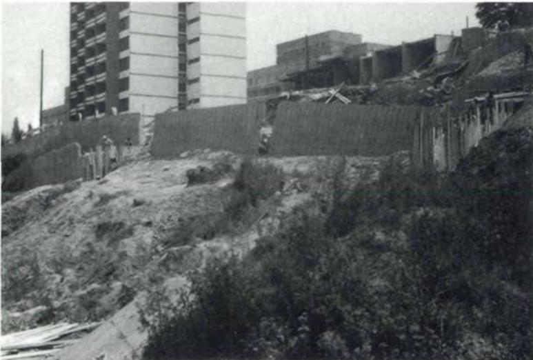
Abb. 10: Salgótarján. Durch Hangrutschung zerstörte Stützmauer und im Bau befindliche Wohnhochhäuser.
