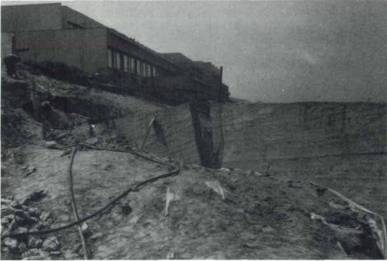
Abb. 9: Salgótarján. Durch Hangrutschung zerstörte Stützmauer und Gebäudeschäden.
