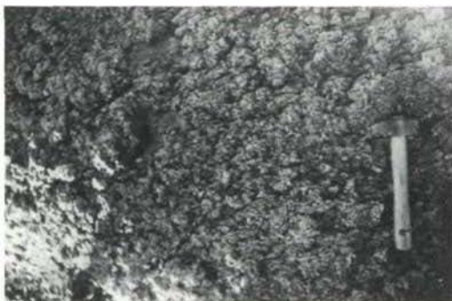
Photo 3: freigelegte Tonschiefer, feinklüftig zerfallend
