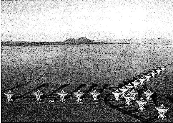
Abb. 2.3a Radioastronomische Viel-Element-Antenne ( \varnothing je 25 m), VLA (Very Large Array), Socorro, USA (NRAO/AUI/NSF)
