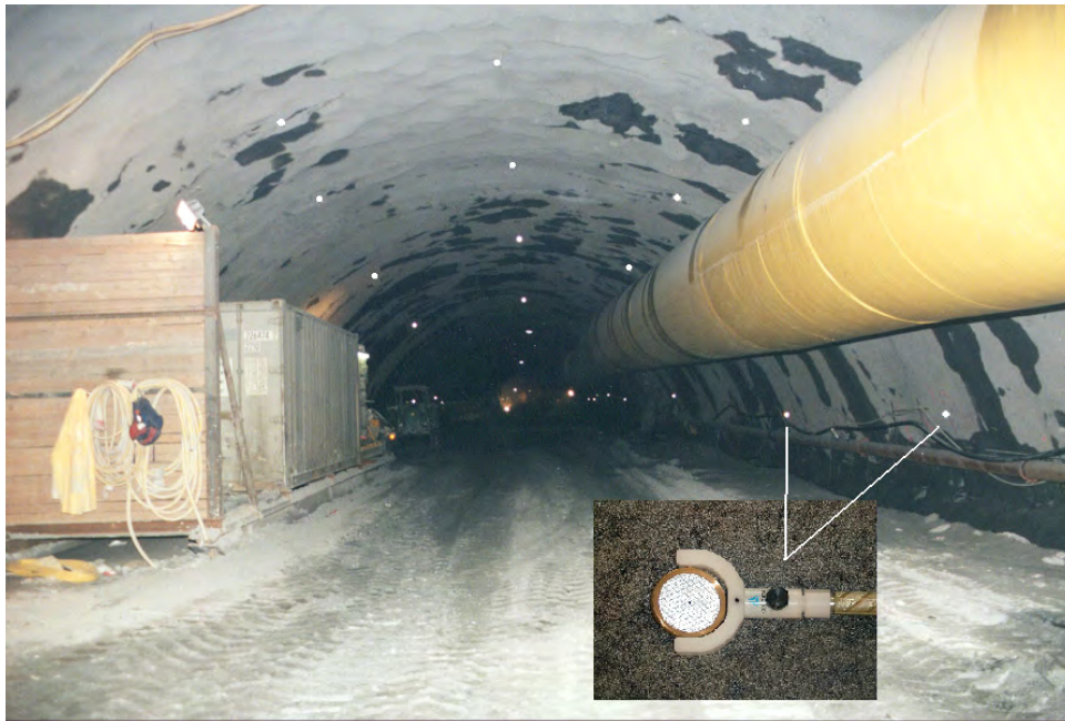
Abb.5: Anordnung von Messpunkten und Messquerschnitten im Tunnel
