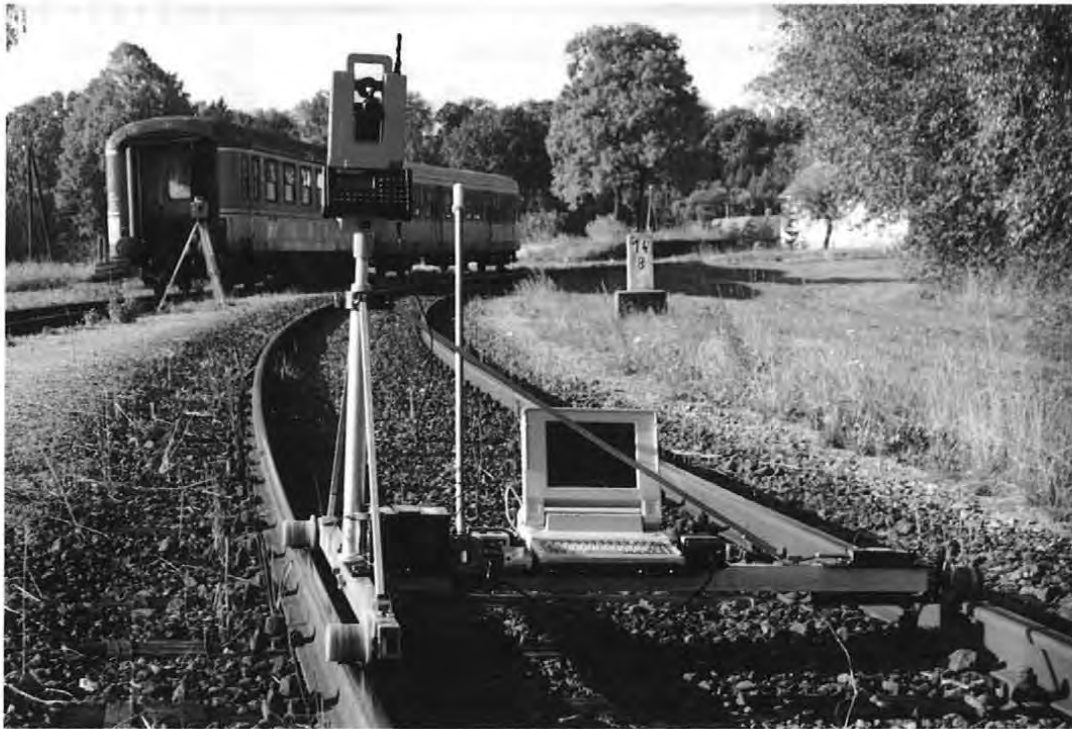
Abb. 5.2: Gleisaufnahme mit einem Meßrobotersystem
