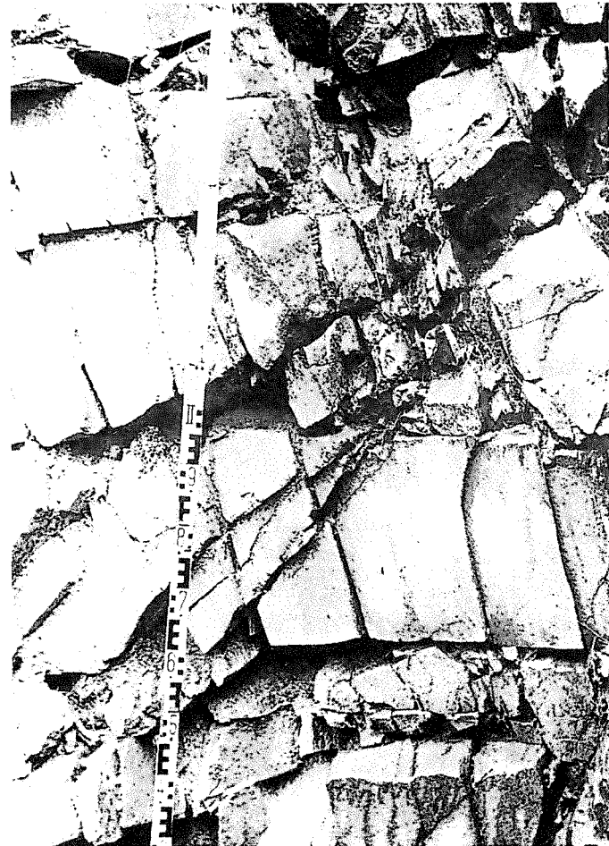
Durch Hangbewegungen zerlegter Kluftkörperverband
