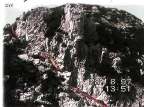
Deutlich erkennbare aktive Störungszone im Plassenkalk (Blockwerk links unterhalb der roten Linie im Bild)
