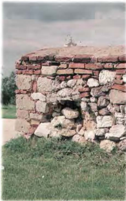
Friedhofsmauer in Fallbach: Fünf verschiedene Bausteine
