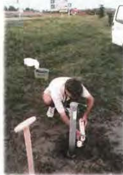
Herstellung einer Grundwassermeßstelle und Abdichtung des Ringraumes.
