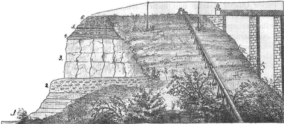
Fig. 22. Profil der Lehne des Iserthales beim Viaducte in Záměstek nad Ohří (Station Krnsko-Stranov). (J.) Iserfluss. 1. Tiefste Lagen der Trigoniaschichten. 2. Bank mit grossen *Exogyra conica*. 3. Podvinecer Baustein. 4. Sandige Knollenpläner mit zahlreichen *Serpula socialis*. 5. Zwei schwache Quaderbänke durch Plänerlagen getrennt. 6. Die höchsten Lagen der Trigoniaschichten (vielleicht schon Bryozoenschichten).
