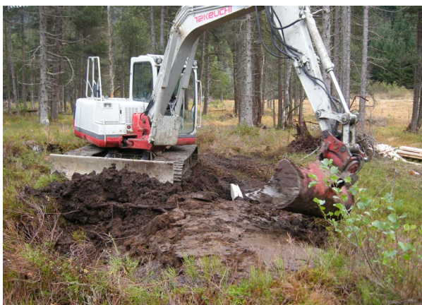
Abb. 10 und 11: Der Bauschacht wurde verfüllt und die Holzspundwände wurden mit dem anfallenden Aushubmaterial (Torf) abgedeckt und angeböscht, um sie vor Witterungseinflüssen und Verrottung zu schützen. Zuletzt wurden die vegetationsfreien Stellen auf den Staus mit den zwischengelagerten »Torfziegeln« abgedeckt. Oberhalb der Staus verblieben Mulden größtenteils ohne Vegetationsabdeckung, die sich bald mit Wasser füllten. Als Nebeneffekt der Hochmoorrenaturierung entstanden neue Kleingewässer (vgl. Abb. 42) (Fotos: Georg Amann).
