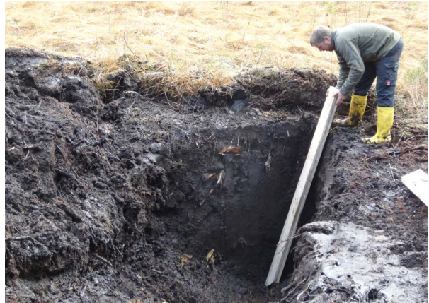
Abb. 6 und 7: Quer zum Graben wurde ein Schacht in der Länge des Stauwehres ausgehoben. Die oberste Torfschicht samt Vegetation wurde in »Torfziegeln« abgehoben und zur späteren Abdeckung des Bauwerks zur Seite gelegt (Foto: Georg Amann). Danach wurde der Schacht ausgehoben, bis die Grabensohle erreicht war (Foto: Anne Puchta).
