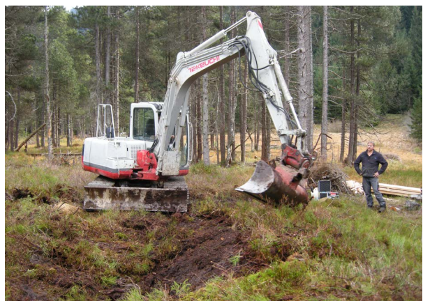
Abb. 10 und 11: Der Bauschacht wurde verfüllt und die Holzspundwände wurden mit dem anfallenden Aushubmaterial (Torf) abgedeckt und angeböscht, um sie vor Witterungseinflüssen und Verrottung zu schützen. Zuletzt wurden die vegetationsfreien Stellen auf den Staus mit den zwischengelagerten »Torfziegeln« abgedeckt. Oberhalb der Staus verblieben Mulden größtenteils ohne Vegetationsabdeckung, die sich bald mit Wasser füllten. Als Nebeneffekt der Hochmoorrenaturierung entstanden neue Kleingewässer (vgl. Abb. 42) (Fotos: Georg Amann).
