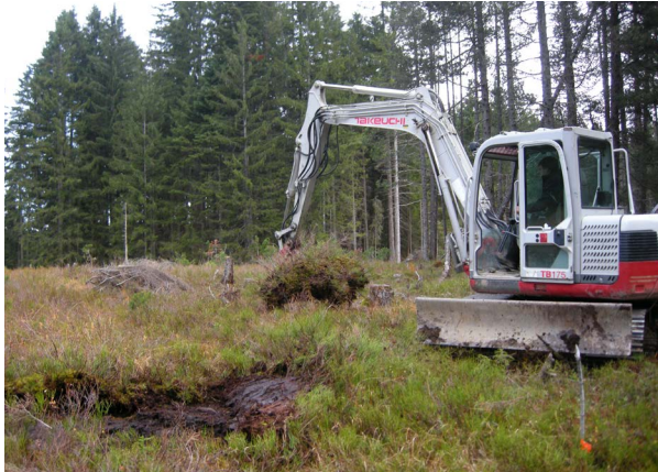
Abb. 6 und 7: Quer zum Graben wurde ein Schacht in der Länge des Stauwehres ausgehoben. Die oberste Torfschicht samt Vegetation wurde in »Torfziegeln« abgehoben und zur späteren Abdeckung des Bauwerks zur Seite gelegt (Foto: Georg Amann). Danach wurde der Schacht ausgehoben, bis die Grabensohle erreicht war (Foto: Anne Puchta).
