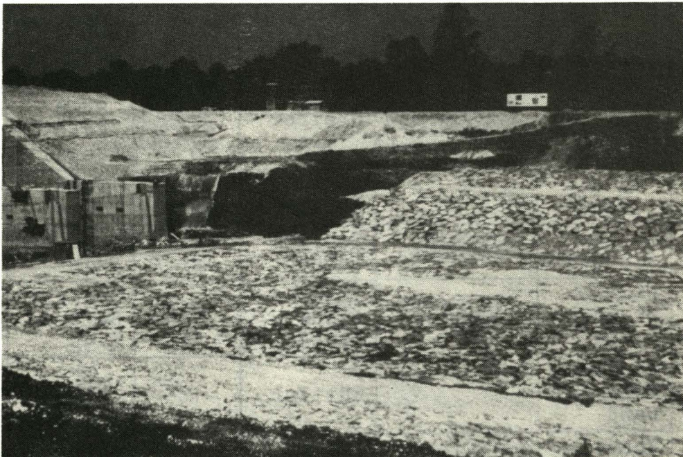
Abb. 2: Baugrube für die Errichtung eines Flußkraftwerkes (Abdichtung mittels Schmalwand)
