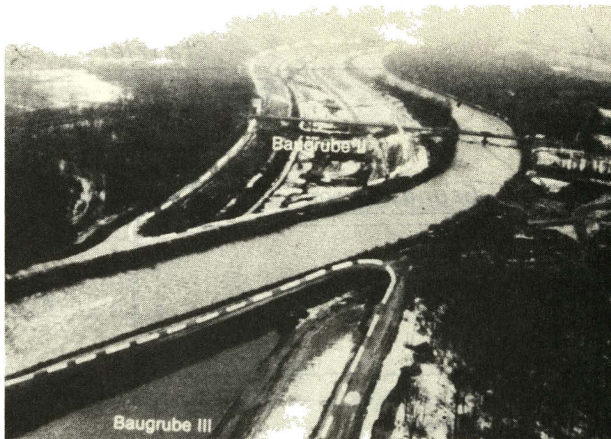
Abb. 3: Unterwassereintiefung eines Flußkraftwerkes (Herstellung des neuen Flußbettes im Schutze einer Schmalwand)
