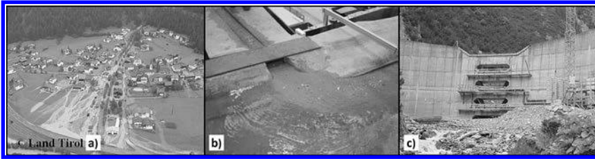
Abbildung 03: Ablagerungen in Schnann unmittelbar nach dem Ereignis am 23. August 2005 (a); Modellversuch mit Fokus auf den Mündungsbereich (Maßstab 1:30) (b); Adaptierung der Rückhaltesperre (c).
