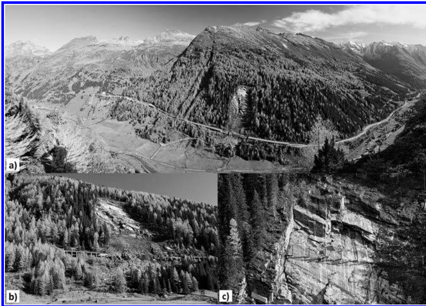
Abbildung 06: Felsgleitung/Felslawine Schildalmgalerie: Überblick mit Verlauf der Felbertauernstraße und der Ersatzstraße (a), Blick von unten auf die Lawinenbahn mit der zerstörten Schildalmgalerie (b). Anrissgebiet mit Hochenergie-Seilsperre (c). Die hangparallele Ausrichtung der Trennflächen ist hier deutlich zu erkennen. Anmerkung: das Anrissgebiet wurde durch nachfolgende Sprengungen verändert.
