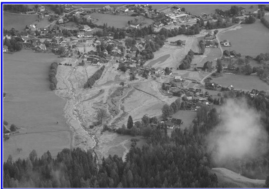
Abbildung 03: Ablagerungen am Schwemmkegel des Tronitzerbachs, Gemeinde Afritz am See. Figure 03: Debris flow deposits on the fan of the Tronitzer creek, community Afritz am See. Quelle: GLB Kärnten Nordost, WLV
