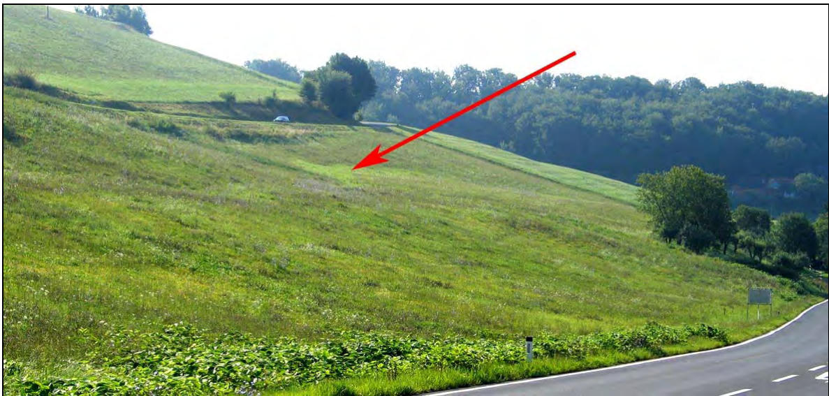
Abb. 6.26: SE gerichteter Blick auf die Bewegung S24a mit einer Übersteilung im oberen Bereich des Hanges, einer Verebnung mit Feuchstellen in der Hangmitte (Pfeil) und einer wulstartigen Verformung am Hangfuß (Bäume).
