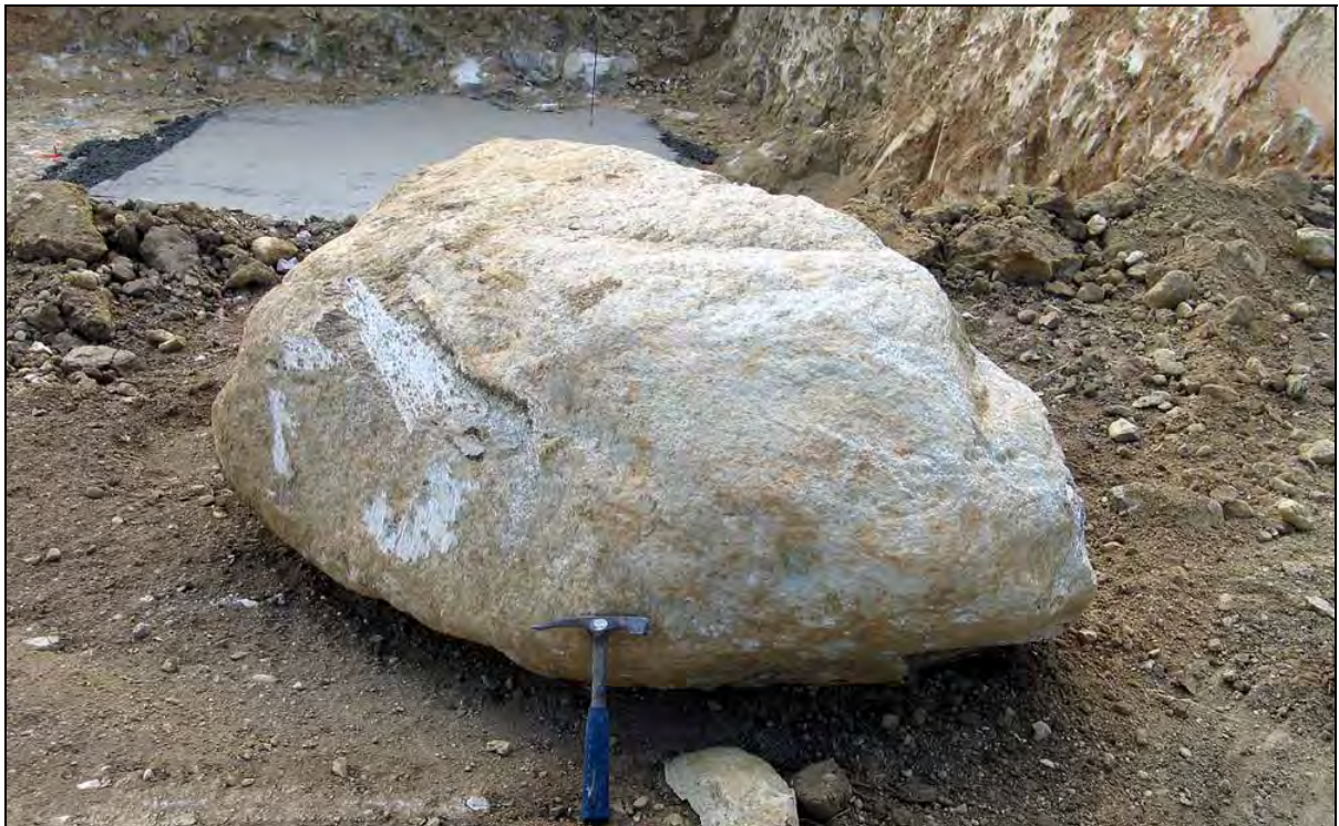
Abb. 4.5: Baugrube in den Rust-Formation am südlichen Ortsrand von Rust. Gut gerundete, kristalline Komponenten mit Durchmessern im m-Bereich wurden freigelegt.
