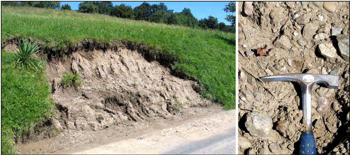
Abb. 4.24: Lokale Rutschungen an einer Böschung eines Güterweges ca. 1 km südlich des Zentrums von Sieggraben verursacht durch die Kriechbewegung N6. Obwohl das anstehende, grobkörnige Material als Brennberger Blockstrom anzusprechen ist (Foto rechts), scheint die Ursache der Bewegung auf Instabilitäten in der Hochriegel-Formation im Liegenden zurückzuführen zu sein.
