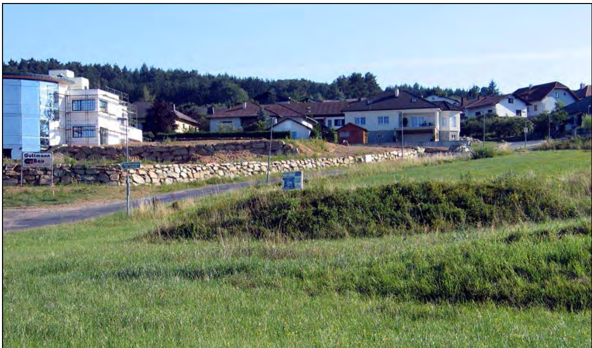
Abb. 6.20: Hangsicherungsmassnahmen durch Steinschüttungen in Rotenturm innerhalb der Bewegung S96. Im Vordergrund sind Hebungen durch Teil-Rotationsbewegungen sichtbar.
