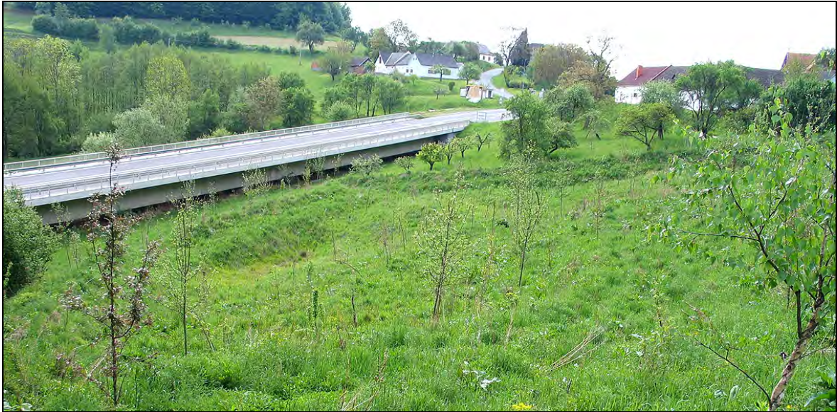
Abb. 6.25: SE gerichteter Blick auf die Morphologie der Kriechbewegung S3 im Vordergrund und die Hangbrücke sowie den weiteren Verlauf der B57 im Hintergrund.
