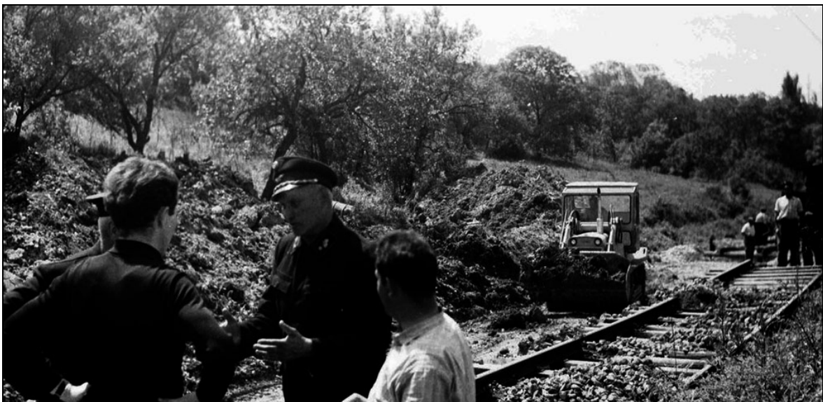
Abb. 4.28: Situation an der Raaberbahn im Jahr 1964, dem Streckenverlauf nach Ungarn folgend unmittelbar nach der 180° Schleife in Draßburg, Blickrichtung W. Ein Teilbereich der Bewegung N4 hat sich beschleunigt und es mussten insgesamt 15.000 m 3 Bodenmaterial aus dem Bereich der Gleiskörper entfernt werden. Hinter den Personen ist die bewegte Masse deutlich zu erkennen. Foto mit freundlicher Genehmigung der Raaberbahn.
