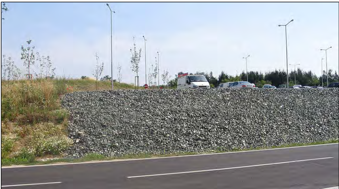
Abb. 5.13: Nordwärts gerichteten Blick auf die sanierte Park & Ride Anlage innerhalb der Bewegung M1 im N von Weppersdorf, die großflächige ausgeführte Steinschüttung ist deutlich zu erkennen..
