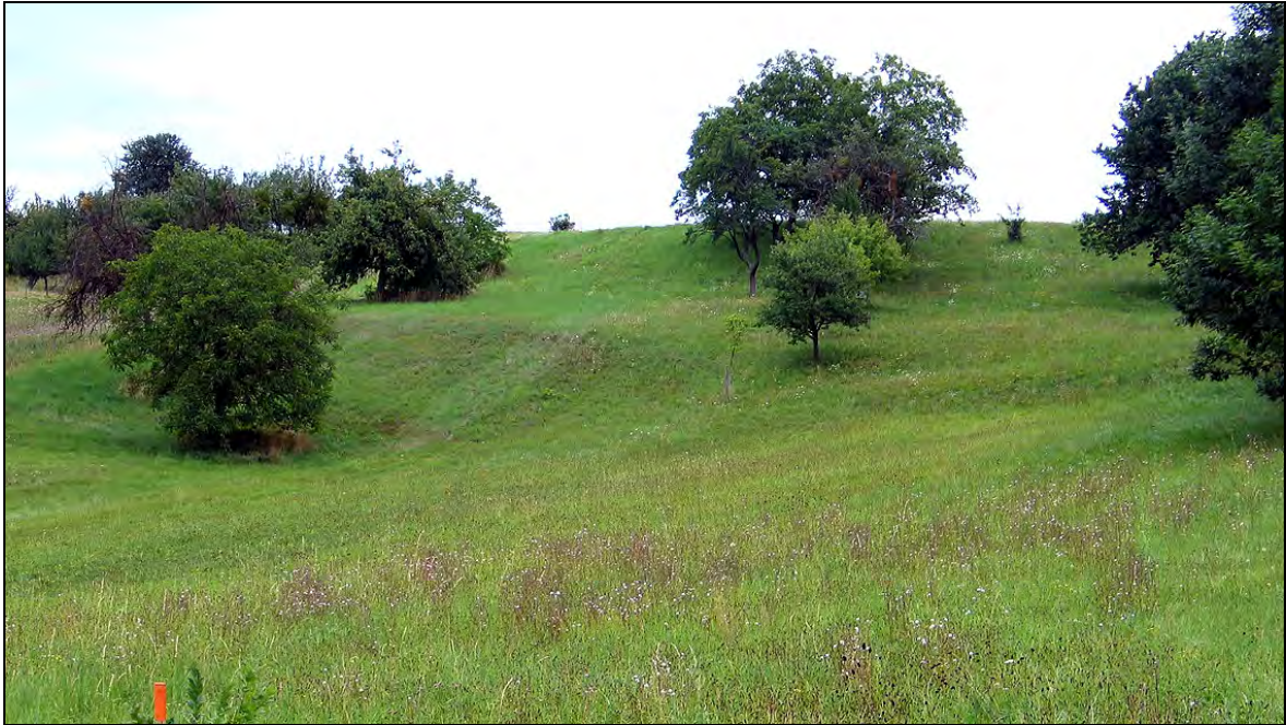
Abb. 5.9: Situation der Kriechbewegung M17 unmittelbar N von Oberrabnitz, Blickrichtung E. Feuchtstellen, großflächige Setzungen, Schrägwuchs der Bäume, wellige Morphologie und übersteilte Hangabschnitte sind zu beobachten.
