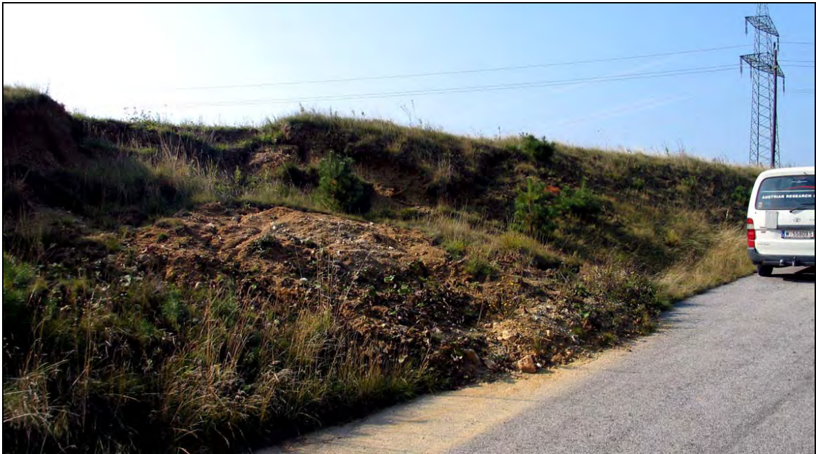
Abb. 5.16: Strasseneinschnitt NW von Markt St. Martin, Blickrichtung S. Rutschung in Lockersedimenten in Form einer Rotationsrutschung.
