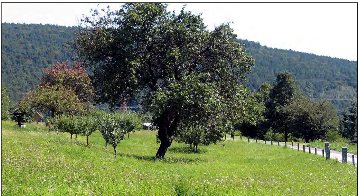
Abb. 4.25: Die genaue Kartierung der Umgebung zeigt Schrägwuchs, Abrisskanten und Feuchtestellen (alles in der Bildmitte) oberhalb der betroffenen Straße und es lässt sich somit die Kriechbewegung N6 abgrenzen.
