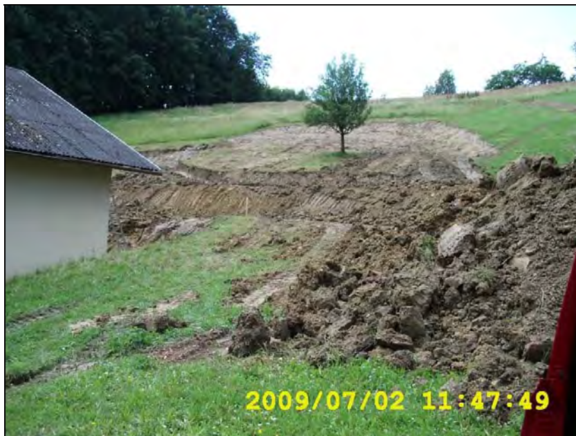
Abb. 6.32: Aufnahmen während der unmittelbar nach dem Auftreten eingeleiteten Sanierung der schnellen Bewegung 34, die Bewegung blieb aber trotz der Erdarbeiten aktiv (Fotos mit freundlichen Genehmigung des Technischen Büros Dr. Josef Hofer).
