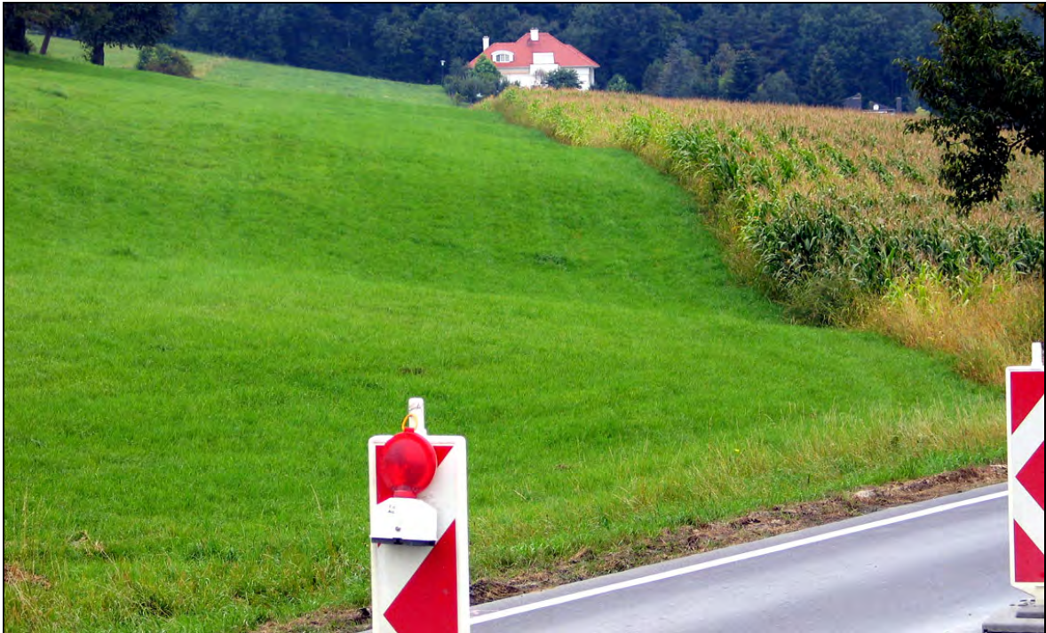
Abb. 6.12: Blick Richtung NW auf die Bewegung S137 von der in Sanierung befindlichen B50 aus.
