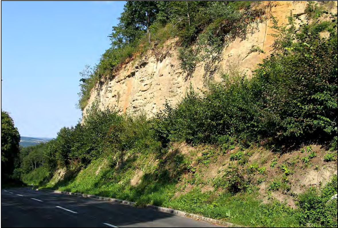
Abb. 4.14: Fast senkrecht stehende, natürliche Böschungen aus Sanden der Sand-Schluff-Fazies der NGZ bei der nördlichen Ortseinfahrt von Wiesen mit Blickrichtung N.
