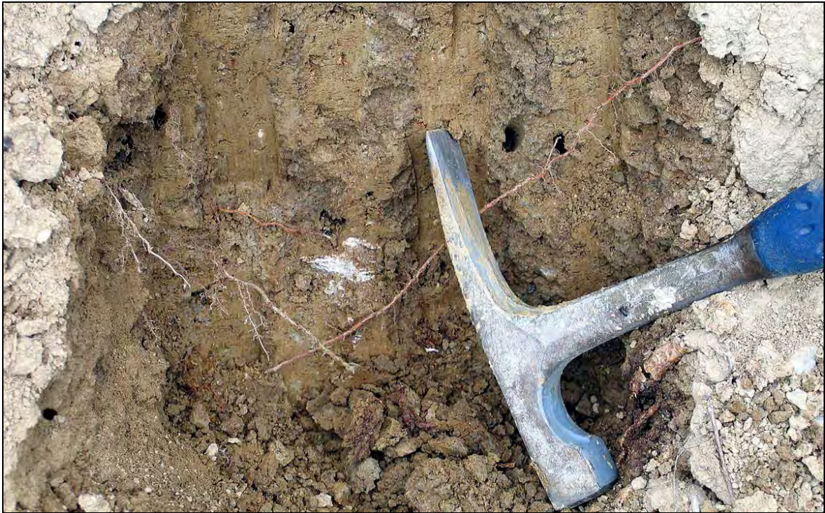
Abb. 5.8: Aufgeschlossenes Material innerhalb der Kriechbewegung M20 SW von Oberrabnitz. Obwohl der Sinnersdorf-Formation zugehörig ist dieses Material frei von grobkörnigen Komponenten, Schluff und Sand dominieren.
