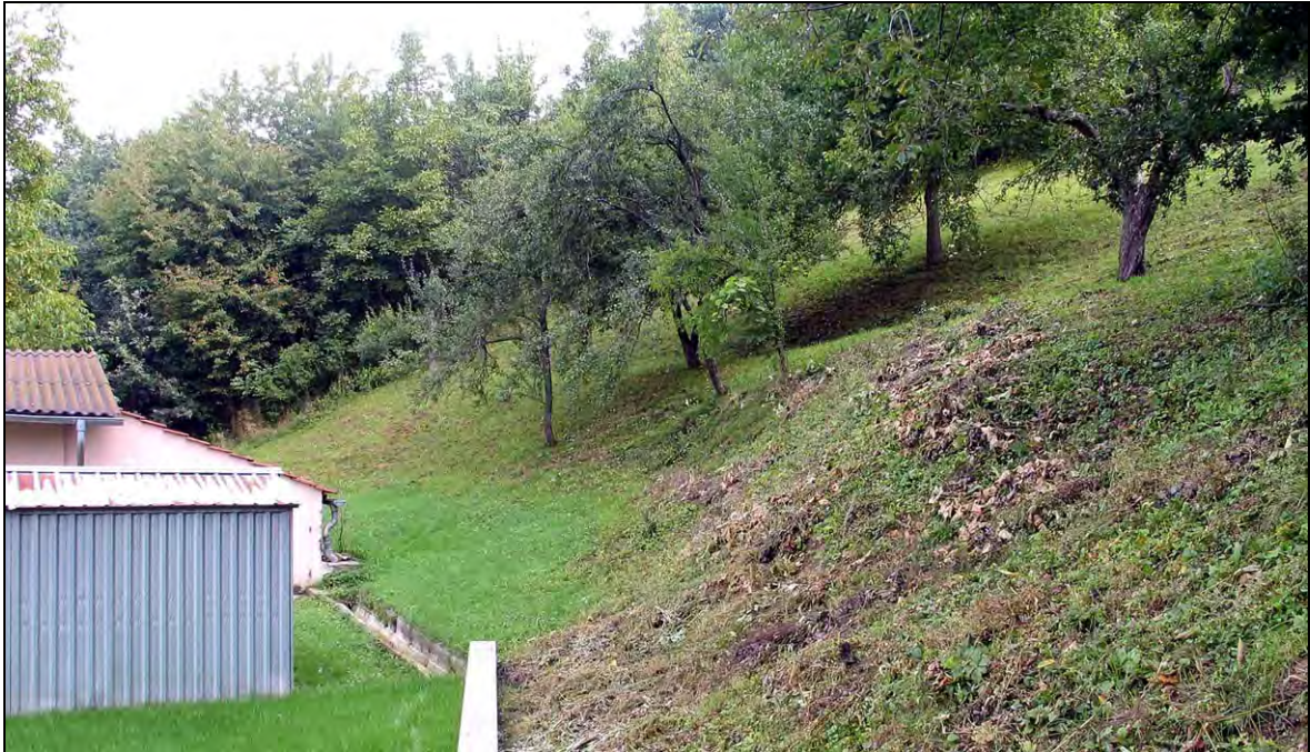
Abb. 6.42: Profilblick mit Blickrichtung N auf die Kriechbewegung S8 mit dem Wirtschaftsgebäude (rosa).
