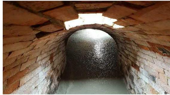
Abbildung 64: Das Verfüllmaterial erreicht durch seine Fließfähigkeit alle Hohlstellen, Quelle: NÖ Straßendienst
