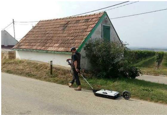
Abbildung 23: Messung mit einer Variante des Bodenradars, Quelle: NÖ Straßendienst
