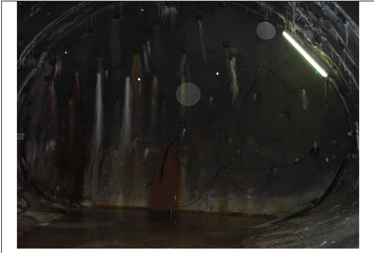
**Abb. 10.** zeigt die Ortsbrust des Tunnels. Von rechts kommt die Stromzufuhr bzw. der Pumpschlauch für die Pegelpumpe in der Mitte unten.
