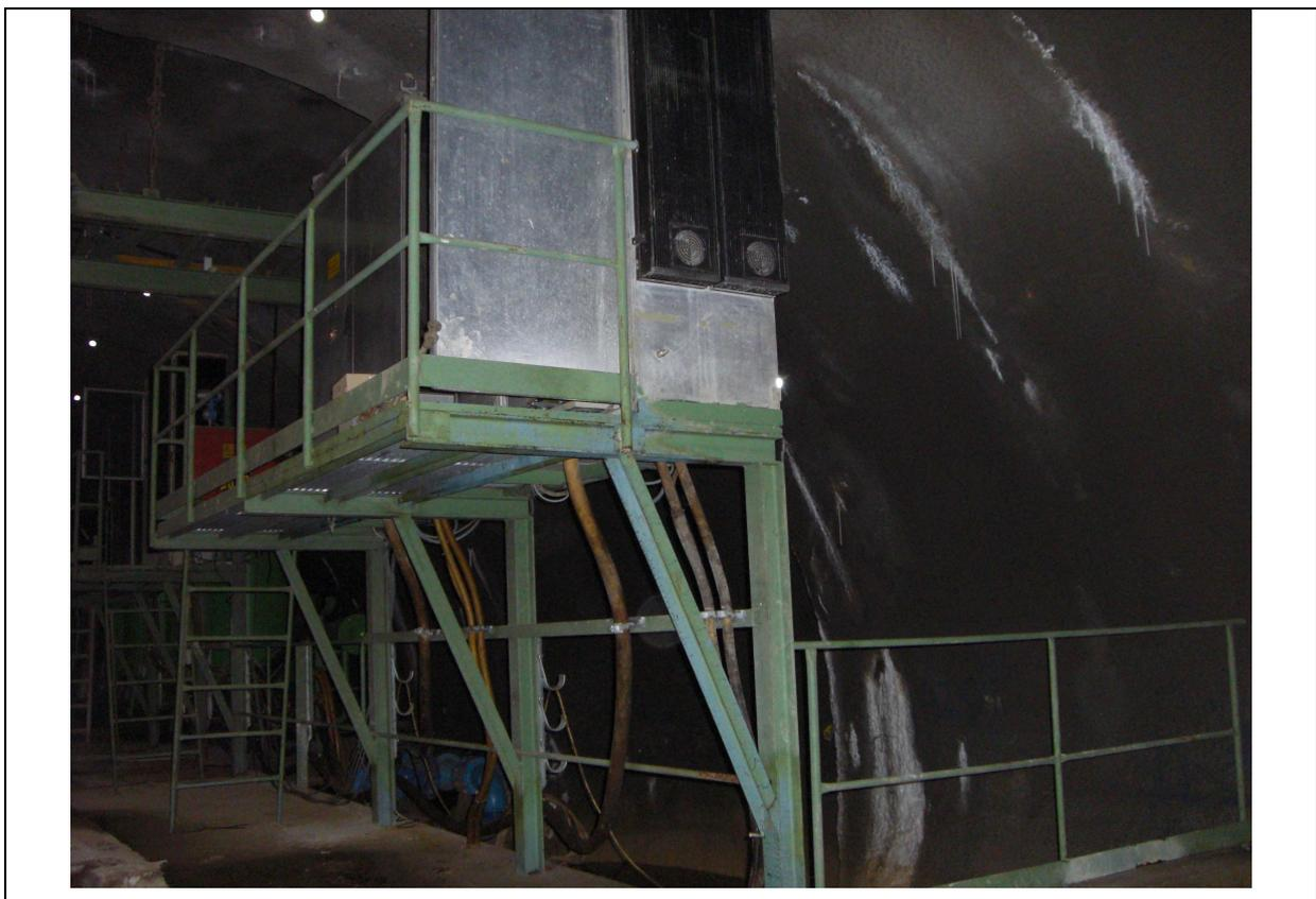
**Abb. 11.** zeigt die Pumpstation II. hinter dem Geländer befindet sich eines der beiden Sammelbecken
