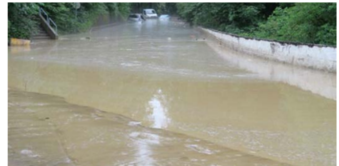
Abbildung 6: Überflutete Zufahrtsstraße und Stauwirkung der Begrenzungsmauer (© KHM Museumsverband, Schloss Ambras).
