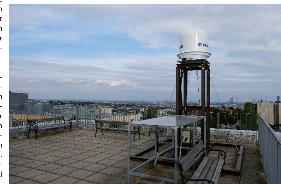
Abbildung 1: Montage der Radarkuppel auf der Dachplattform.
