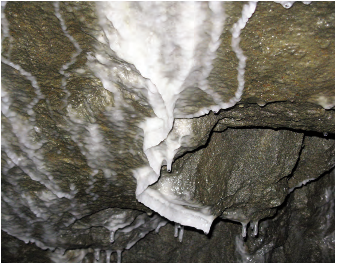
Abb. 146: Sinterfahne im Bereich MP 5A. (Foto: R. Pavuza).
