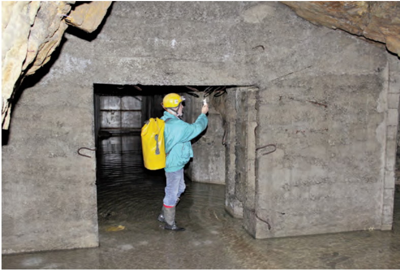
Abb. 21: Eingang 3 (Steinbruch) mit der im Stolleninneren liegenden Gasschleuse bzw. mit dem variablen und bis zu ca.16 m zurückreichenden Wasserrückstau. (Foto: W. Greger).
