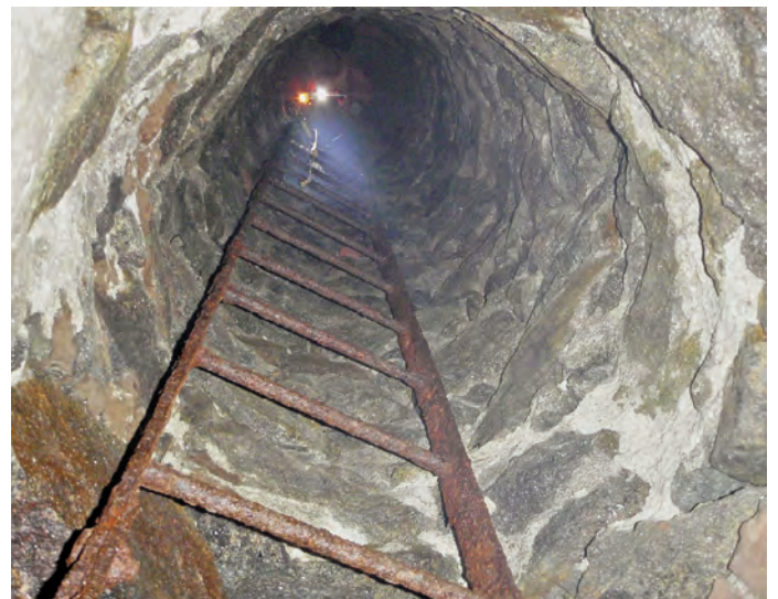
Abb. 11: Die dritte Leiter – Aufstieg in die oberste, heute mit einer Betondecke abgeschlossene Kammer. (Foto: E. Fritsch).
