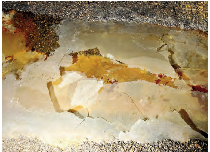
Abb. 86: Calcitplättchen im Gerinne des Hauptganges bei MP 7, Breite des Gerinnes ca. 50 cm. (Foto: H. Thaler).
