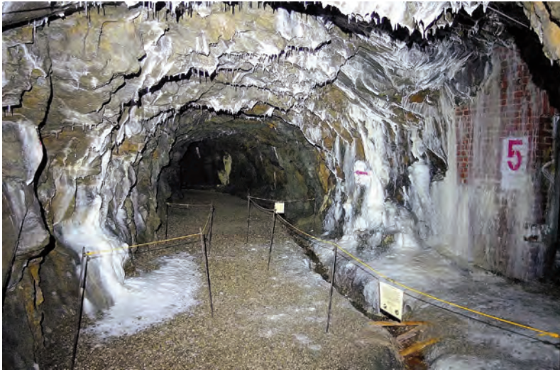
Abb. 16: Ein besonders repräsentativer Abschnitt mit Wand- und Bodenversinterungen im südlichsten Stollengang an der Abzweigung MP 5. (Foto: E. Fritsch).
