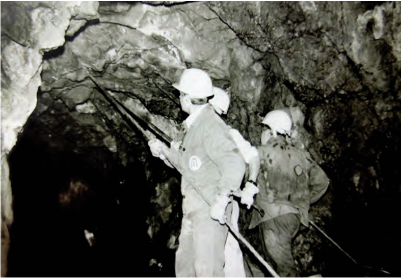
Abb. 31: Bauarbeiten zur Sanierung des Stollens um 1978/79. (Foto: AStL., Sch B 29f).
