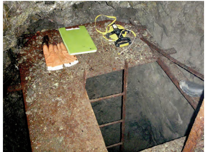
Abb. 10: Der nicht sehr einladende, in 7,5 m Höhe gelegene Zwischenboden des nach oben führenden Notausstieges unweit des Felsenkellers. (Foto: E. Fritsch).
