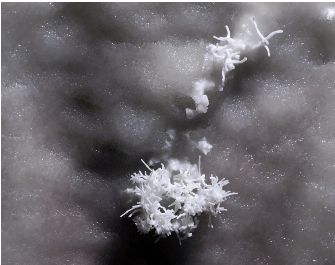
Abb. 148: Nicht leicht auf dem weißen Wandhintergrund zu erkennen sind die ebenfalls weißen und zarten Aragonit- Ausblühungen beiderseits des Türrahmens bei MP 5. Der hier gezeigte Bildausschnitt beträgt ca. 7x4 cm. (Foto: H. Thaler).
