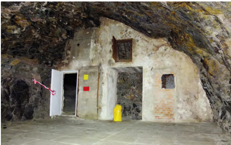
Abb. 8: Durch die geöffnete Tür (links) gelangt man aus dem Keller in den 2,5 m höher liegenden, 1944 erbauten Luftschutzstollen. Die Verbindung wurde nach dem Krieg zugemauert und war zumindest 1976 noch immer verschlossen. (Foto: E. Fritsch)
