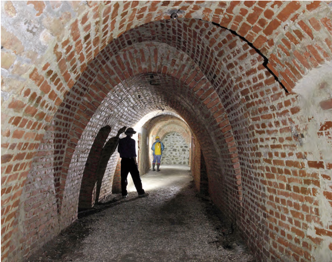
Abb. 143: Im nördlichsten Teil (MP 3E) der Stollenanlage war es aus statischen Gründen erforderlich, eine Gewölbeausmauerung mittels Ziegel durchzuführen. (Foto: H. Thaler).
