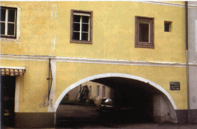
Abb. 10: Gewölbe über dem früheren Werkskanal im Messingwerk Möllbrücke (vgl. Abb. 5 und 7); Haus heute im Besitz von Dr. Thaler (Foto: Ucik, 2000)
