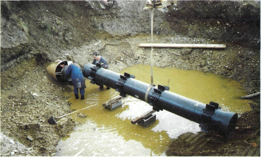
Abb. 6: Einbau einer Transportleitung unter der Autobahn
