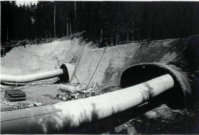
Abb. 2: Tunnel durch den Ehrentaler Berg, im Bau. Foto: stud. rer. nat. Martin LEUTE, Sommer 1993.
