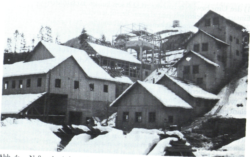
Abb. 4: Naßmechanische Aufbereitung und Flotationsanlage, letztere im Bauzustand
