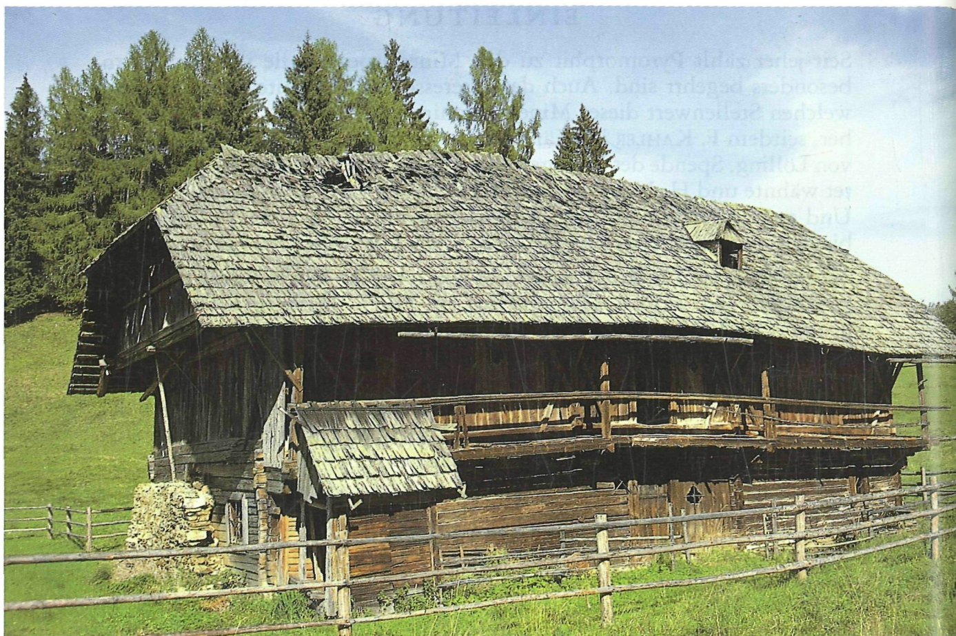
Abb. 1: Hutmannhaus, Kulmitzen No. 8.
