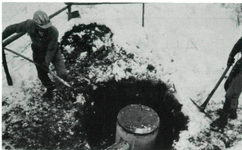
Abb. 2: Sicherungsarbeiten am Schacht. Photo: Harald LANGER.
