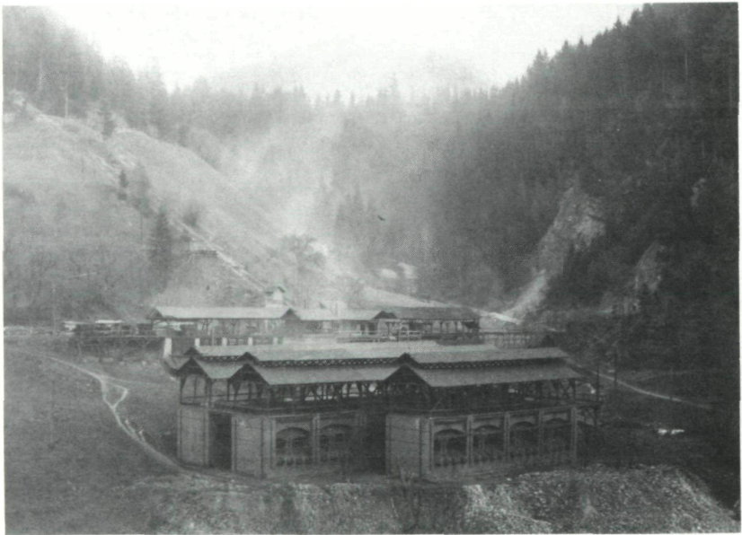
Abb. 18: Röstanlage in Hüttenberg, Baubestand zwischen 1915 und 1926 (vgl. Abb. 16). Undatierte Fotografie im Besitz von H. SCHENN, Knappenberg.
