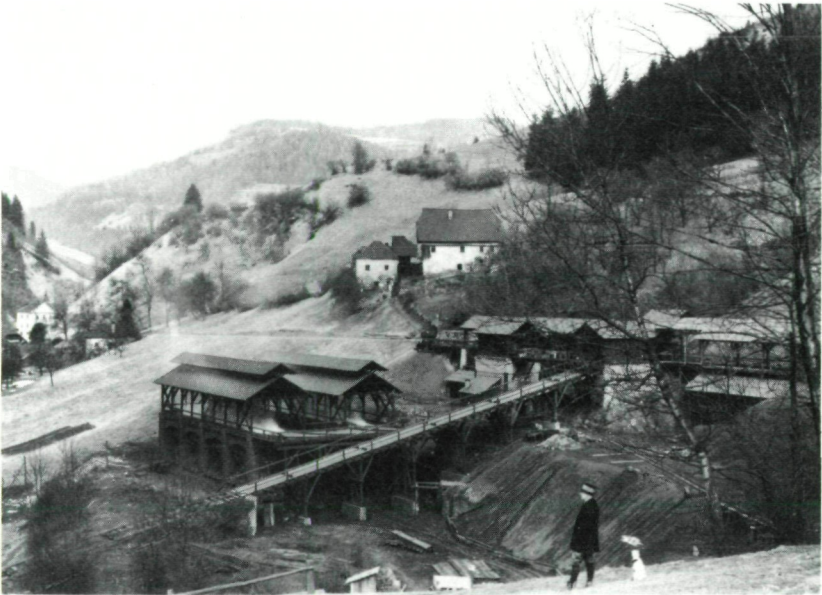
Abb. 15: Röstanlage (zwei Gruppen zu je vier Schachtöfen) in Hüttenberg beim Fußpunkt der Globitschbremse um 1910. Undatierte Fotografie im Besitz von H. SCHENN, Knappenberg.
