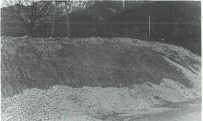
Abb. 2: Eiszeitliche Stauseeablagerungen in neuer, teilweise schon angeschotterter Straßenböschung an der Straße Bleiberg-Labientschach in Bleiberg-Kreuth, Kärnten, mit Rinnenbildung infolge starker Regenfälle (Fotos: E. STREHL, 22. 10. 1979)
