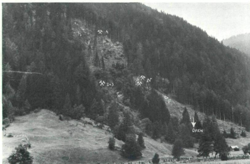
Abb. 1: Ansicht des Geländes des Goldbergbaues SW Oberdorf bei Rennweg (Blick etwa vom Feuerwehrrüsthause in Oberdorf gegen SW). N... Nikolai-Stollen (2 Mundlöcher), P... Pinge (= ? Mittlerer Stollen?), 2, 3, 4... div. namenlose Stollen.
