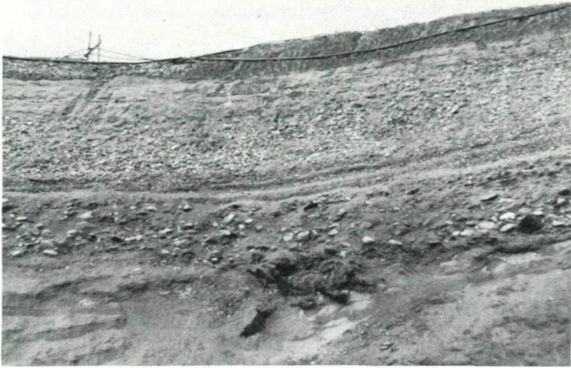
Abb. 1: Die Nordostwand der Baugrube:
